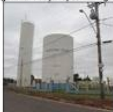
Figura 22 – Poço Alpes das Águas
