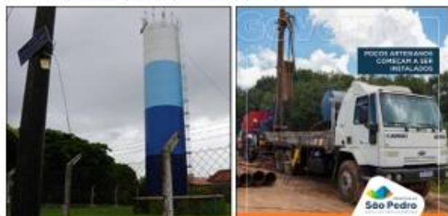
Figura 21 - Reservatório de 100 mil litros (Jardim Botânico) e imagem de divulgação das obras para instalação de poços artesianos pela Prefeitura de São Pedro.
