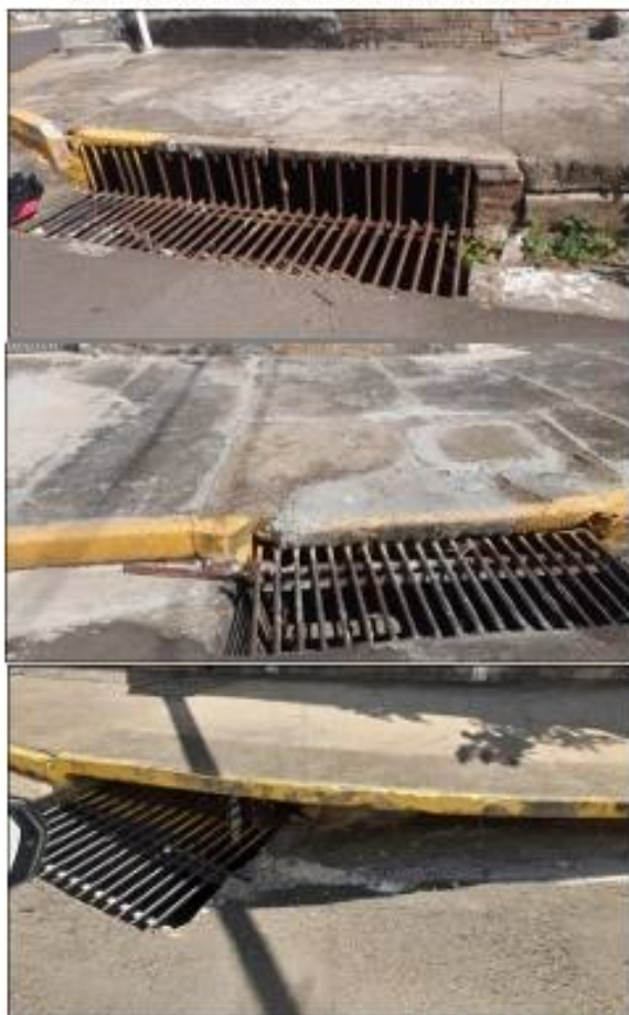
Figura 90 - Dispositivos de microdrenagem em São Pedro.
