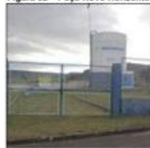
Figura 32 – Poço Novo Horizonte
