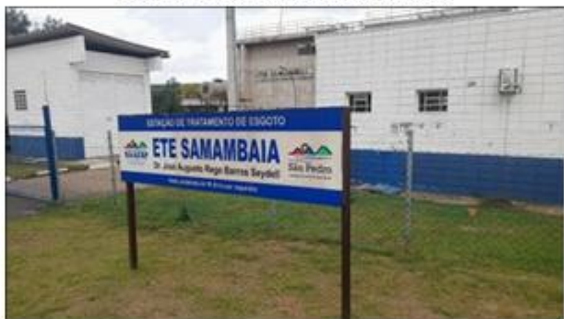
Figura 46 - Entrada da ETE Samambaia. Coordenadas – Lat: 22°33'54.62"S / Long: 47°54'42.06"O
