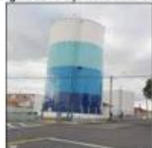
Figura 28 – Poço Nova Estância
