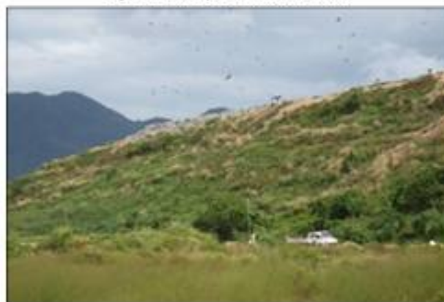
Figura 76 - Exemplo de aterro controlado.
