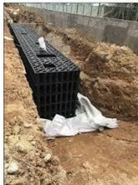
Figura 138 - Sistemas modulares de armazenamento pluvial.
