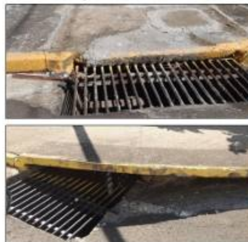
Figura 56 – Bocas coletoras.
