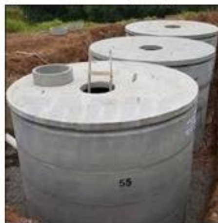
Figura 137 - Tanque de detenção de água de chuva.
