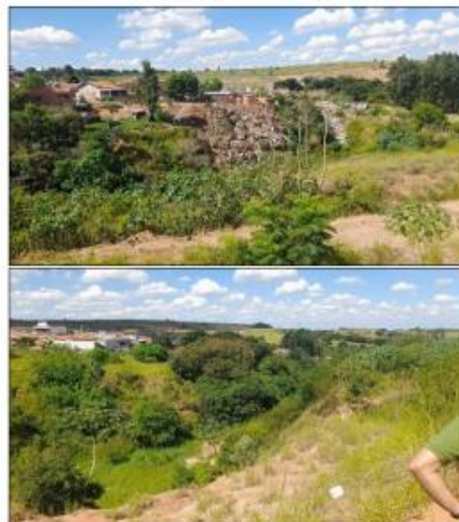
Figura 88 - Processo erosivo controlado no bairro São Dimas. Coordenadas – Lat: 22°33'23.00"S Long: 47°53'28.68"O
