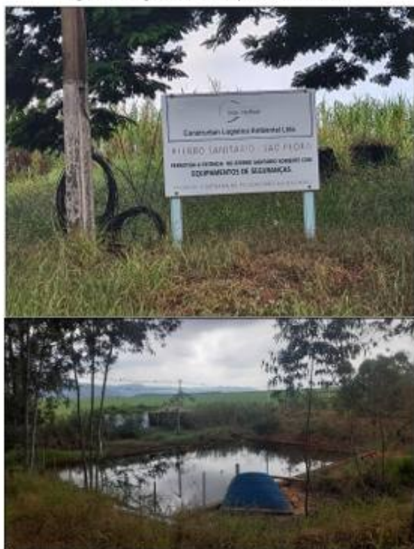
Figura 78 – Antigo Aterro Sanitário presente em São Pedro.
